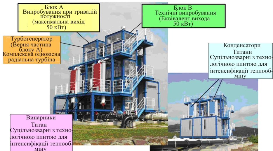
Рис. 2. Демонстраційний ОТЕС потужністю 50 кВт на острові Кумеїма [5].
